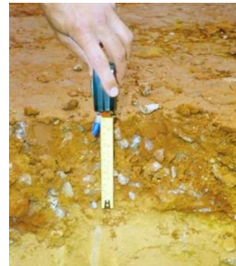
Figura 3.12 – Camada compactada de solo laterítico-agregado de granulação grossa
