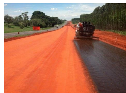
Figura 3.14 – Aplicação de imprimadura betuminosa sobre base de solo arenoso fino laterítico
